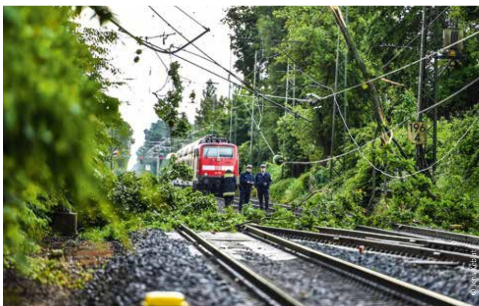
Durch das Unwetter waren zahlreiche Oberleitungen auf die Gleise gestürzt. Hier die Strecke Emsdetten – Rheine.
