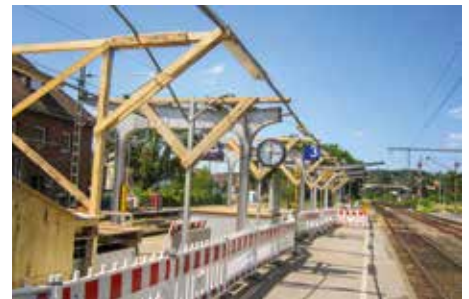
Das alte Bahnsteigdach wird abgerissen und durch ein neues ersetzt.
