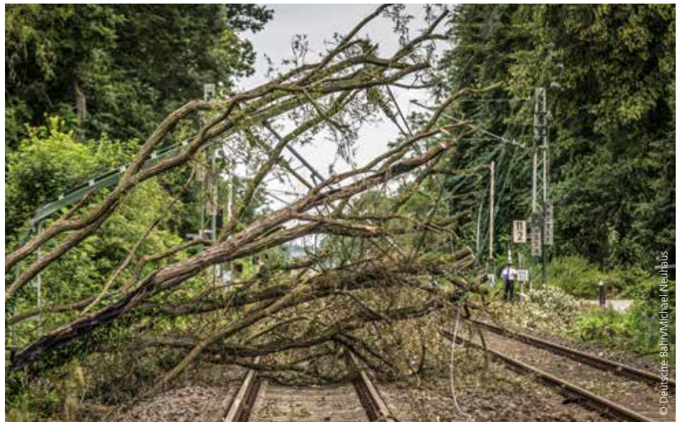
Schäden an der Strecke der S6 durch das verheerende Unwetter vom Pfingstmontag bei Ratingen-Ost.
