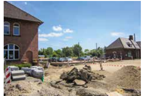
Am Bahnhofsvorplatz wird bereits intensiv gearbeitet.
